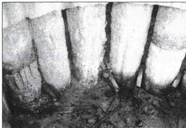
Obr. 14 Vyústenie horizontálnych odvodňovacích vrtov do studne v Handlovej.
